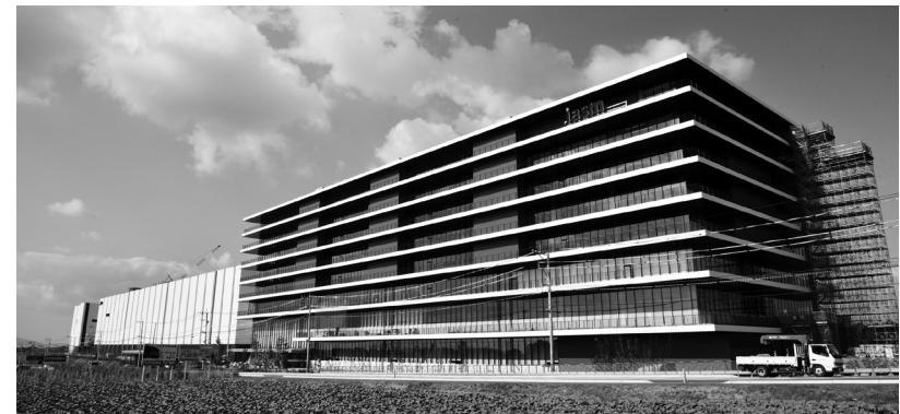
▲県道大津植木線沿いに建つTSMCの子会社JASMの新工場(手前はオフィス棟)
