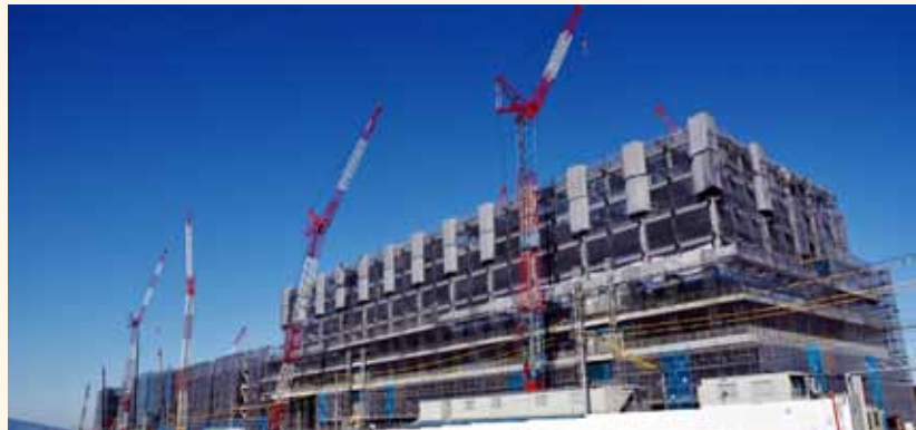
▲菊陽町で建設が進むTSMCの新工場
